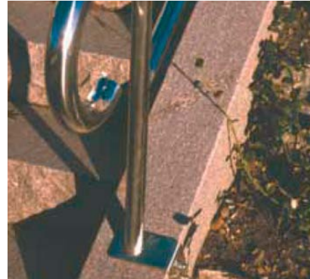
Fig 7.8 Innfesting av rustfritt rekkverk i trappevange av granitt.
