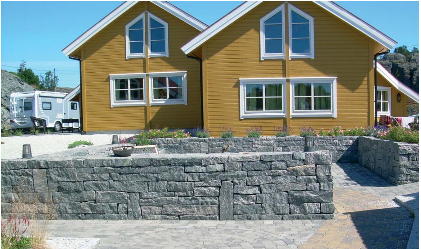
Tosidig mur forblendet med klipt murstein fra Førde Granitt AS. Foto: Øystein Menes
