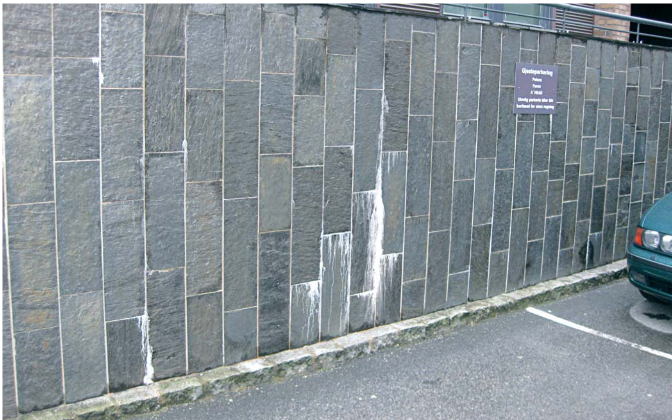
Skjemmende kalkutfelling på en vegg kledd med Ottaskifer. Foto: T. Holstad
