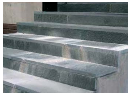
Fig 7.10 Kalk- og saltutfellinger fra sement skjemmer trappen. Kan skyldes feil sement, fersk betongstamme og store mengder vann som transporteres gjennom settemørtelen.
