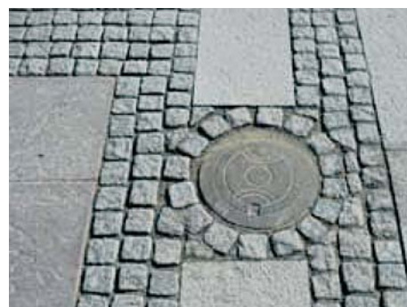
Fig 6.19 Gatestein rundt kum gir god tilpasning mot belegget.
